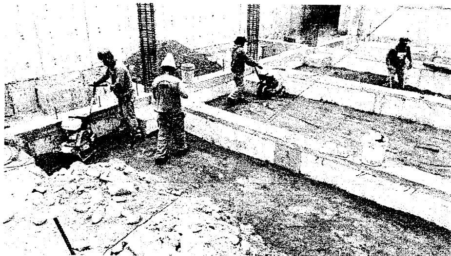
COMPACTACION DE BASE GRANULAR PARA PISOS
